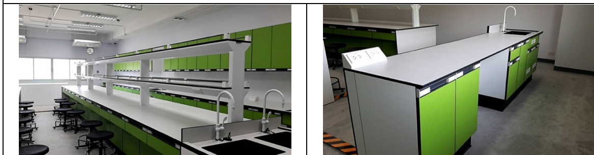
การเดินระบบน้ำในห้องปฏิบัติการ อาคารใหม่
