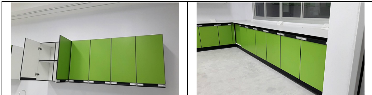
ระบบตู้เก็บสารเคมีและอุปกรณ์ในห้องปฏิบัติการ อาคารใหม่
